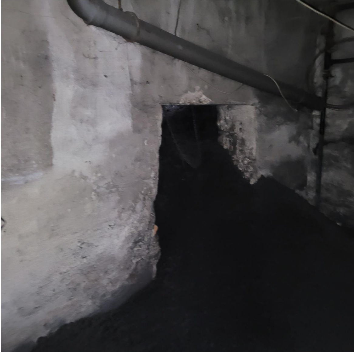
Fot. 4 Widok istniejącego magazynu paliwa
